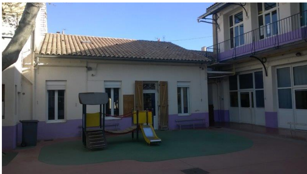
Vue des bâtiments depuis la cour.
