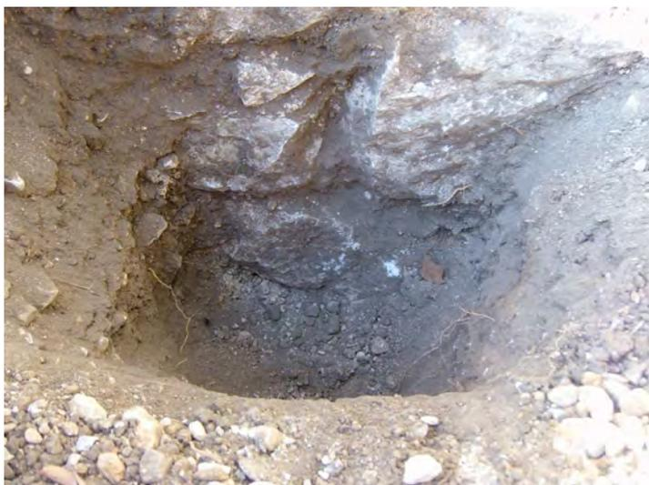
Une seconde reconnaissance a été réalisée contre le bâtiment sanitaires en RDC qui sera démolie. On a reconnu un soubassement en pierres maçonneries reposant sur une semelle filante dont l'arase supérieure est située à 70 cm de profondeur. On a noté un débord de 10 cm.
