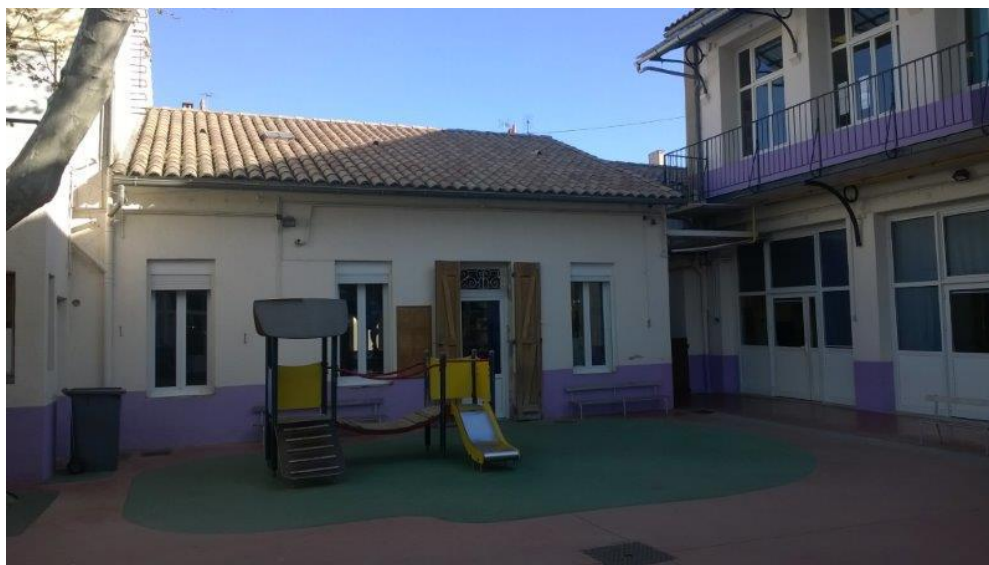
Vue des bâtiments depuis la cour.
