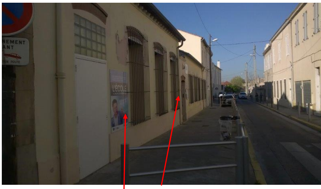
Depuis le Bd Pages : Vue des bâtiments (RdC simple) devant être surélevés
