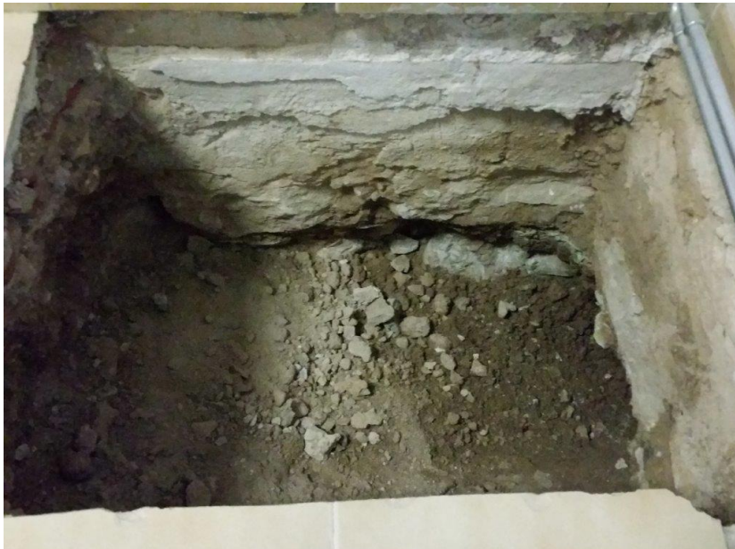
Mur en pierre maçonnées – Pas de débord – profondeur d'assise de 0,70 m / dalle.
