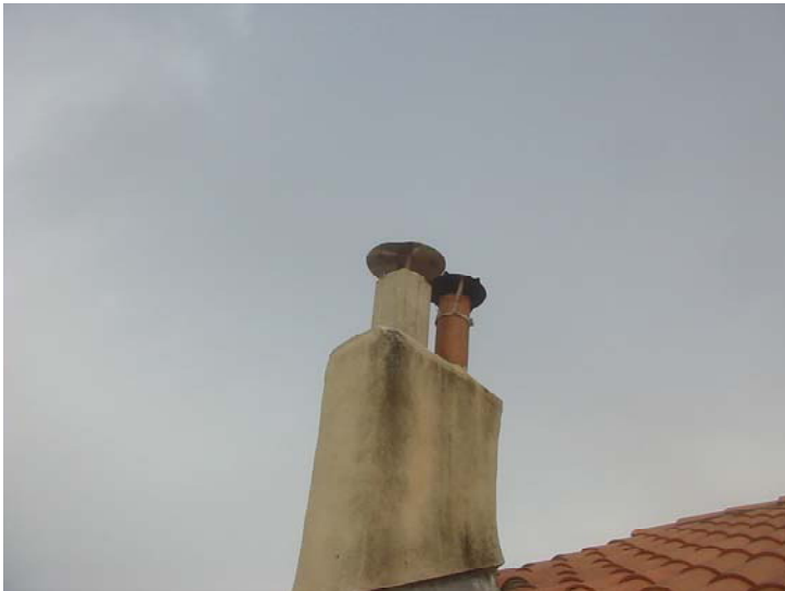
1 CONDUIT EN AMIANTE CIMENT VISIBLE EN TOITURE.
