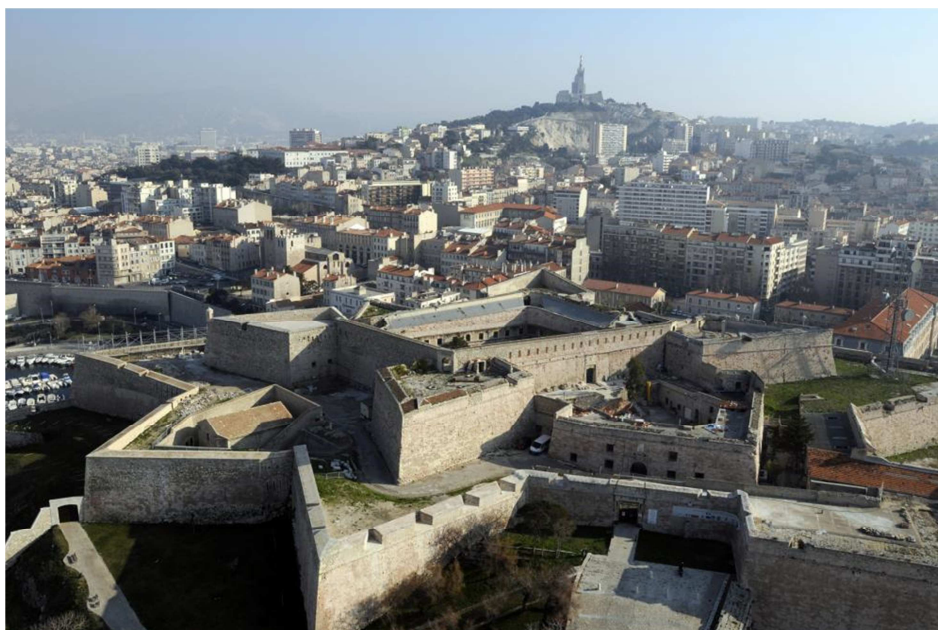
Figure 4 – Environnement de la station Vieux Port – le Fort d'Entrecasteaux
